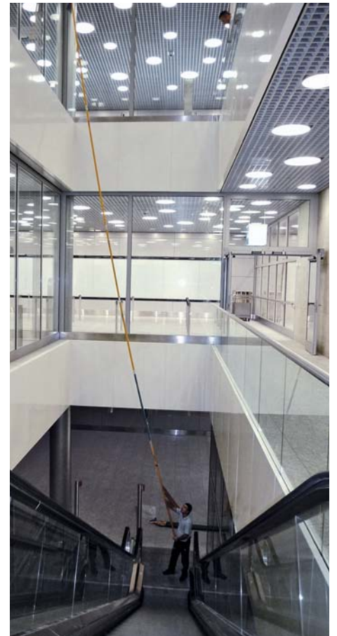
Die Situation für die Reinigung der grossen Glasflächen im Flughafen Zürich ist im Bereich der Rolltreppen sehr komplex: Die Höhe mit 15 m ist nicht mit Arbeitsbühnen zu überbrücken, auch Leitern oder eventuell Kletterer sind in diesem Bereich nicht einzusetzen.
